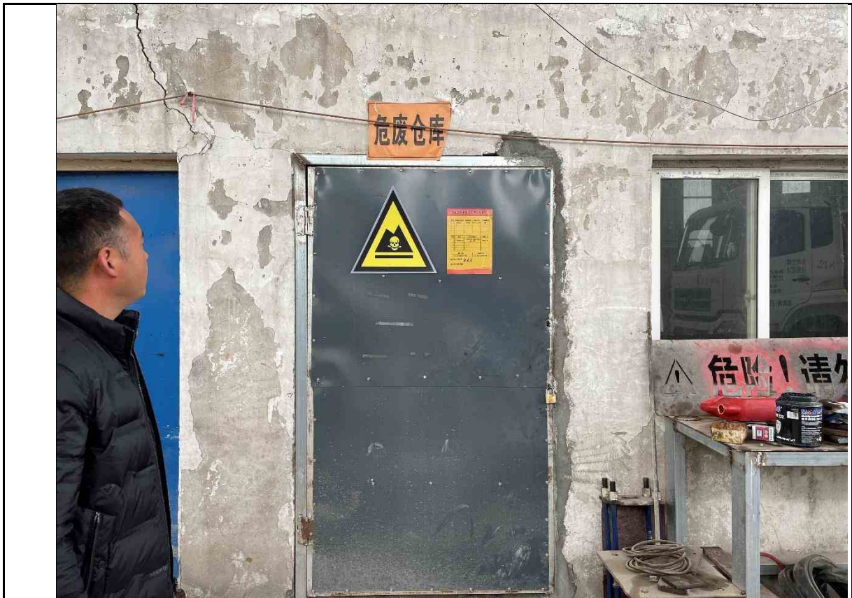
图 2.12-12 企业现状危废仓库
