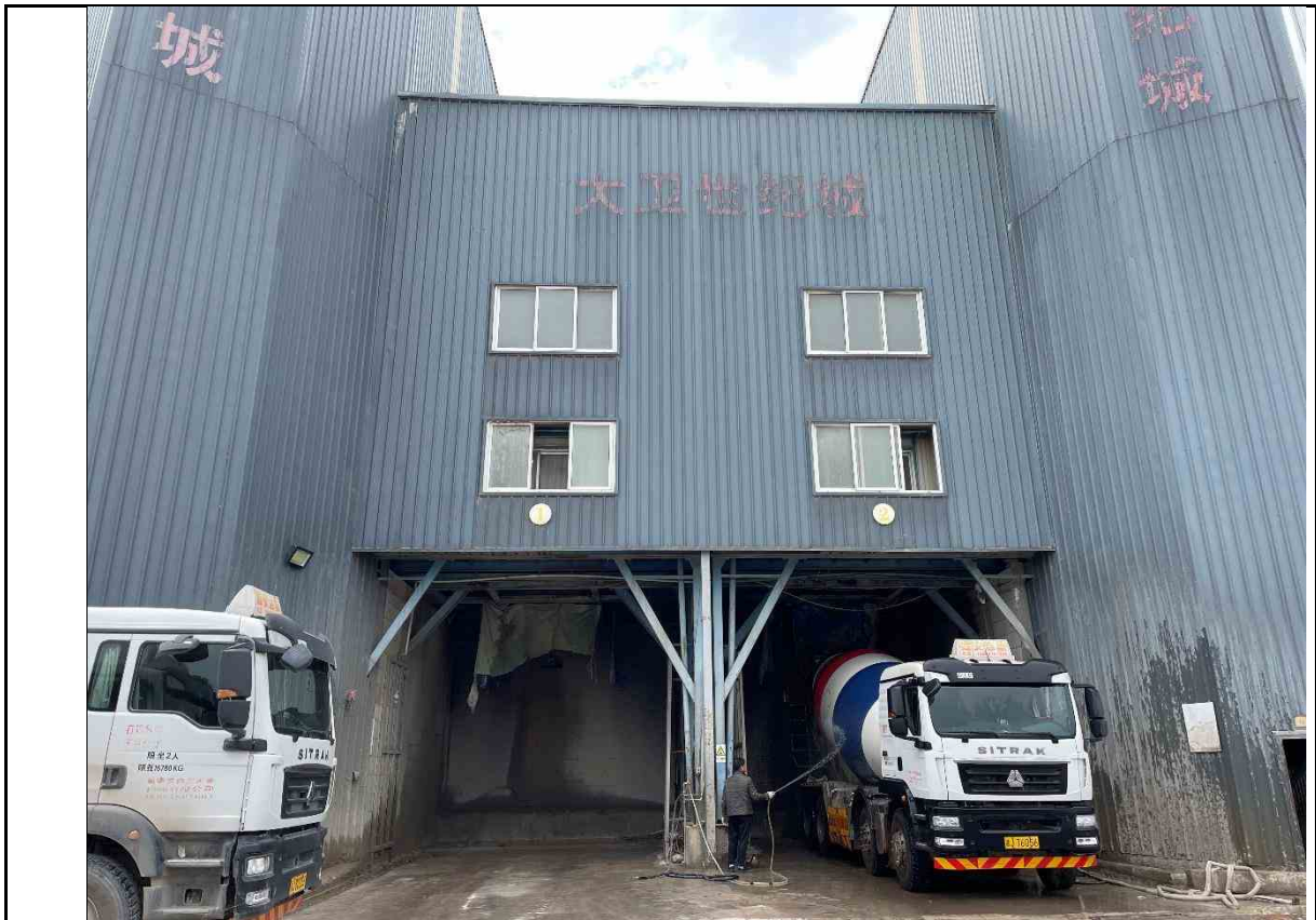
图 2.12-6 企业现状搅拌楼
