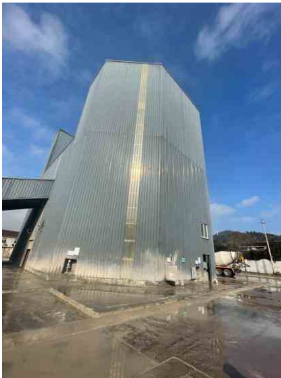
图 2.12-7 企业现状密闭搅拌楼
