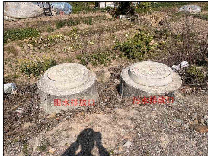
雨、污水排放口（位于项目东北角）
