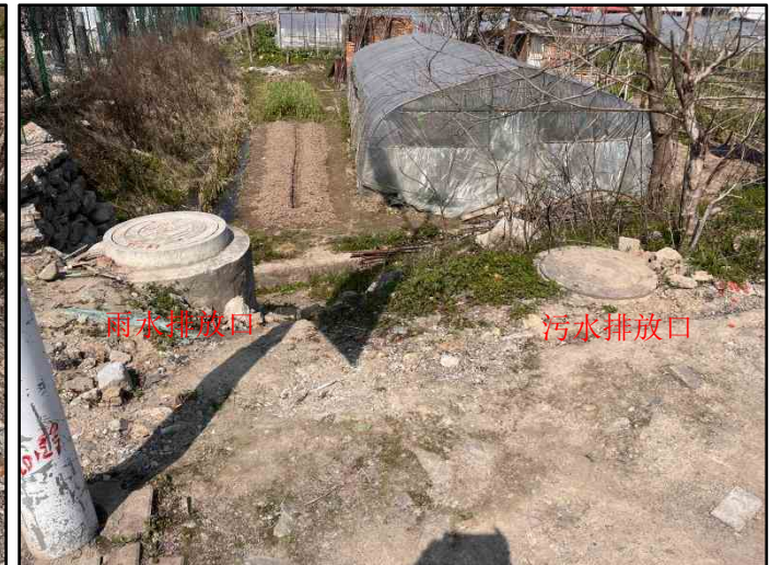
雨、污水排放口（位于项目东南角）
