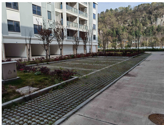
一层室内车库和室外停车位
